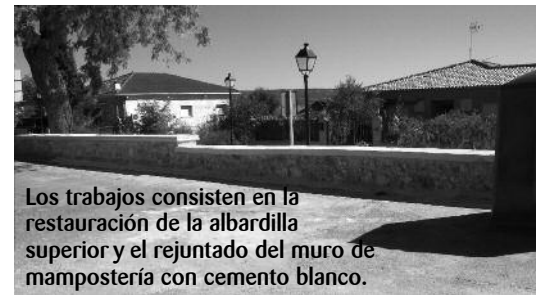
Obras de conservación del muro en calle Guadalajara.
